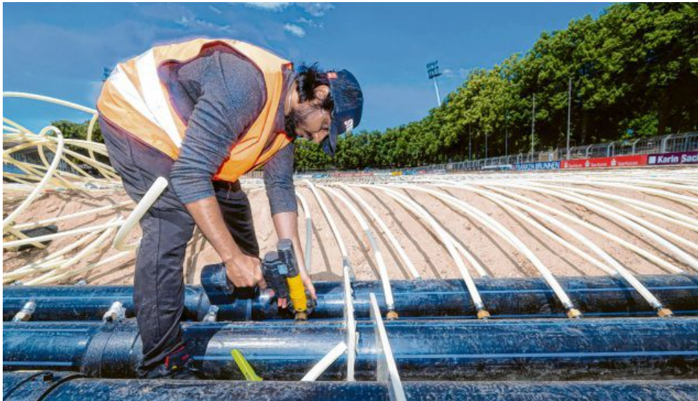
Der Einbau der neuen Rasenheizung auf dem Hauptfeld im Schweinfurter Sachs-Stadion dauerte nur wenige Wochen. Im Bild ist das Verpressen der Leitungen zu sehen.
